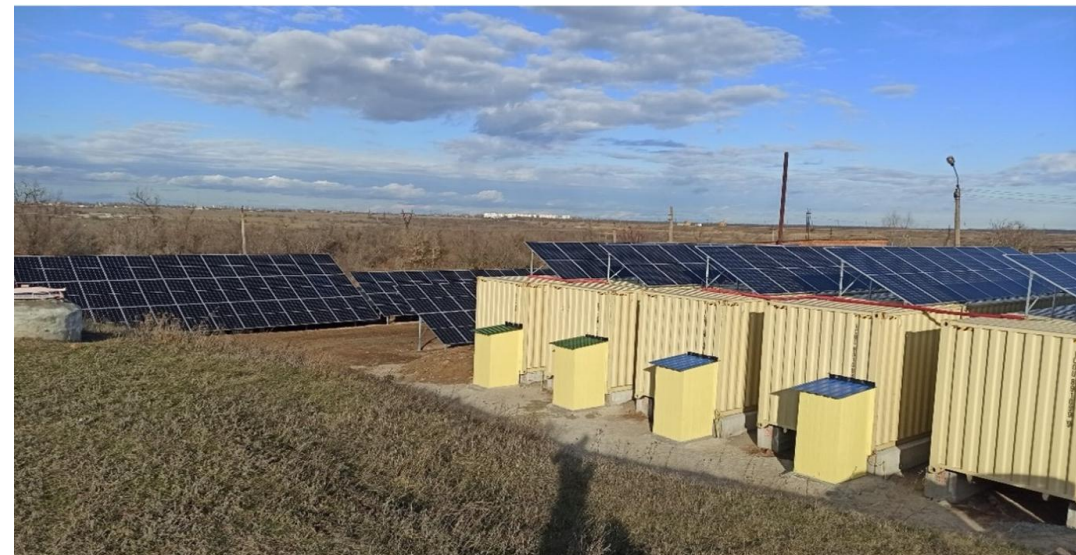
Гібридна сонячна електростанція (сонячна генерація + акумуляторні системи накопичення енергії) на водоканалі Миколаєва
